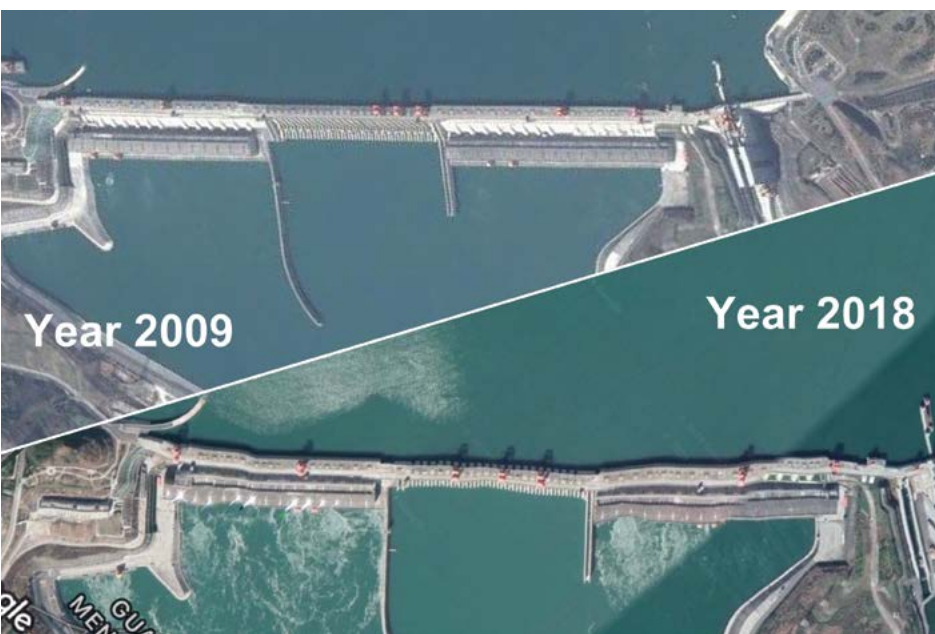
Hình ảnh chụp từ vệ tinh so sánh đập Tam Hiệp năm 2009 và 2018.
