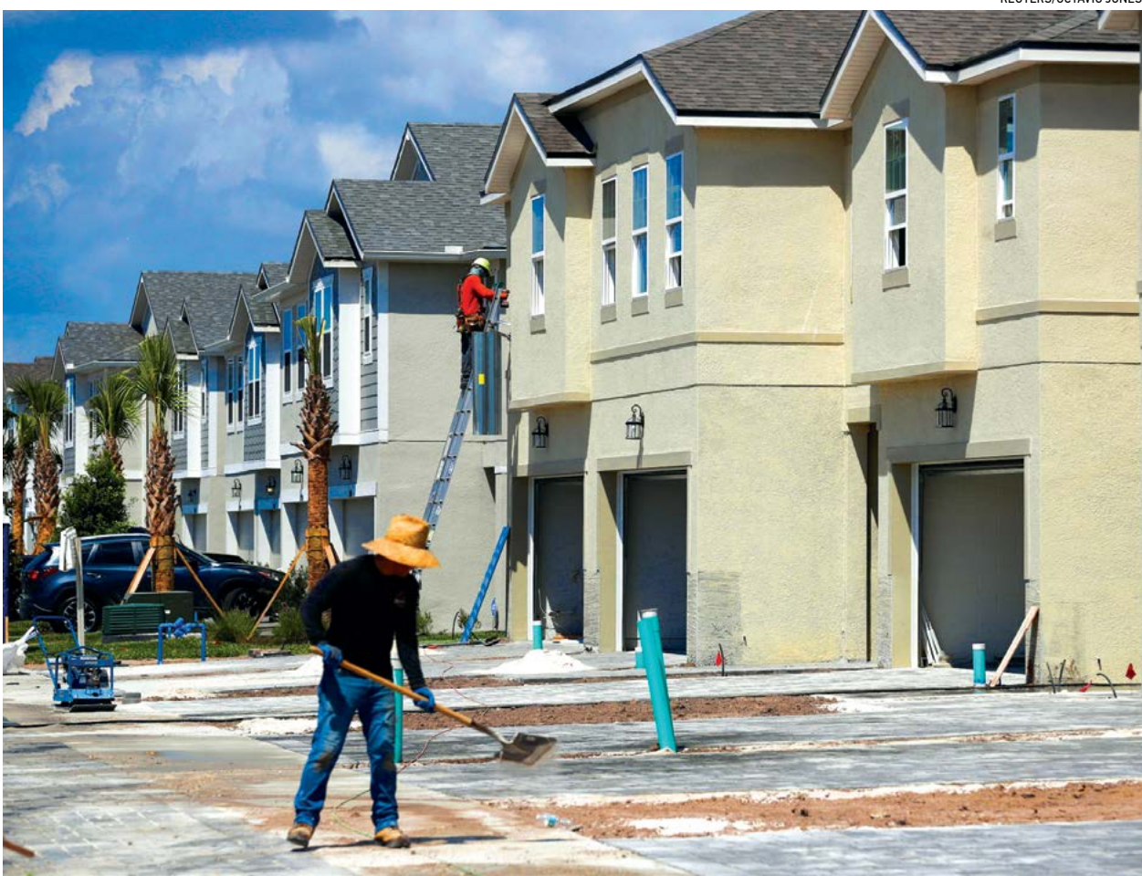
Hình ảnh những ngôi nhà đang được xây dựng ở Tampa, Florida, hôm 05/05/2021.
