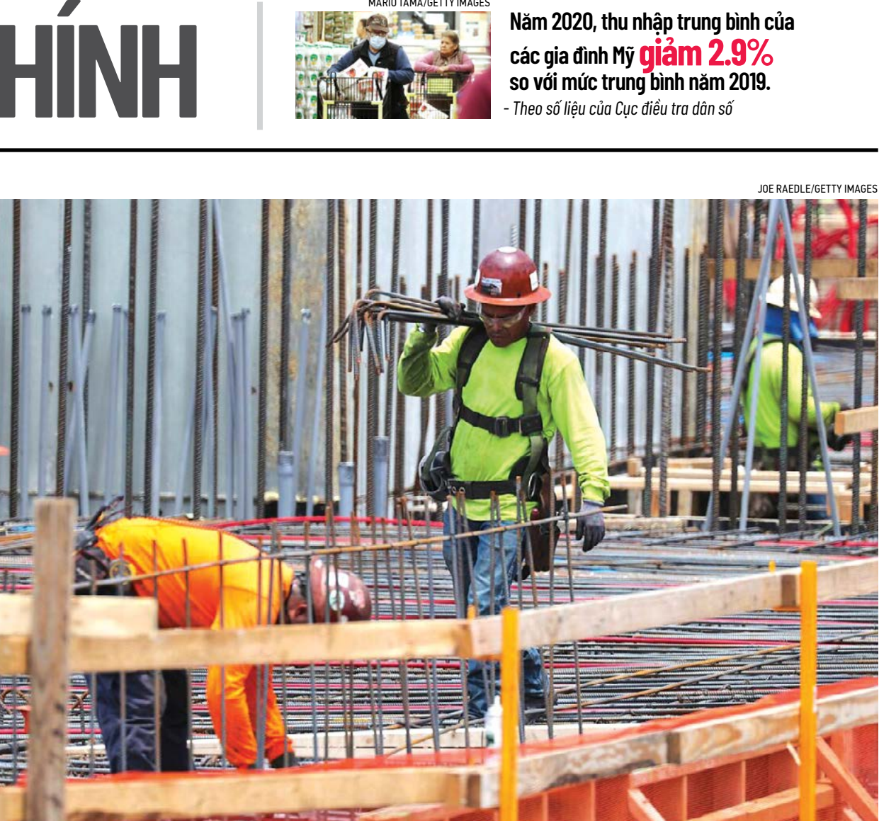
Công nhân xây dựng đang làm việc ở Fort Lauderdale, Florida, hôm 03/05/2019.
