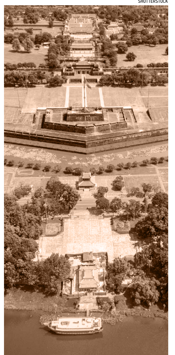
Toàn cảnh Kinh thành Huế nhìn từ trên không.
