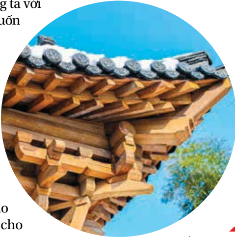
“Dấu Củng” hay tổ hợp các cấu kiện gỗ đan cài vào nhau là một đặc điểm của ngôi nhà gỗ Trung Hoa truyền thống.
