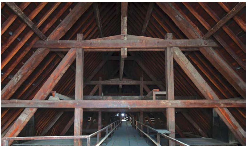
Trước đám cháy: Nóc của Nhà thờ Đức Bà, tên là “La Forêt” (“Khu Rừng”), được xây dựng từ 1,300 cây sồi; có những cây 300 đến 400 tuổi.
