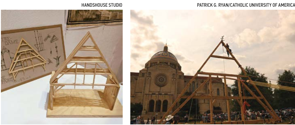
Trái: Dự án giàn đỡ Nhà thờ Đức Bà của Handhouse Studio đã tái tạo một trong những giàn đỡ mái cổ kính nhất của Nhà thờ Đức Bà Paris. Handhouse Studio đã tuân theo thiết kế, sử dụng những vật dụng và kỹ thuật nguyên bản các thợ mộc thời trung cổ đã dùng để xây dựng cấu trúc ban đầu; Phải: Dựng bản sao giàn đỡ mái Nhà thờ Đức Bà lên phía trước Vương cung Thánh đường Đền thánh Quốc gia Đức Mẹ Vô nhiễm Nguyên tội (the Basilica of the National Shrine of the Immaculate Conception) ở Hoa Thịnh Đốn vào ngày 03/08/2021.
