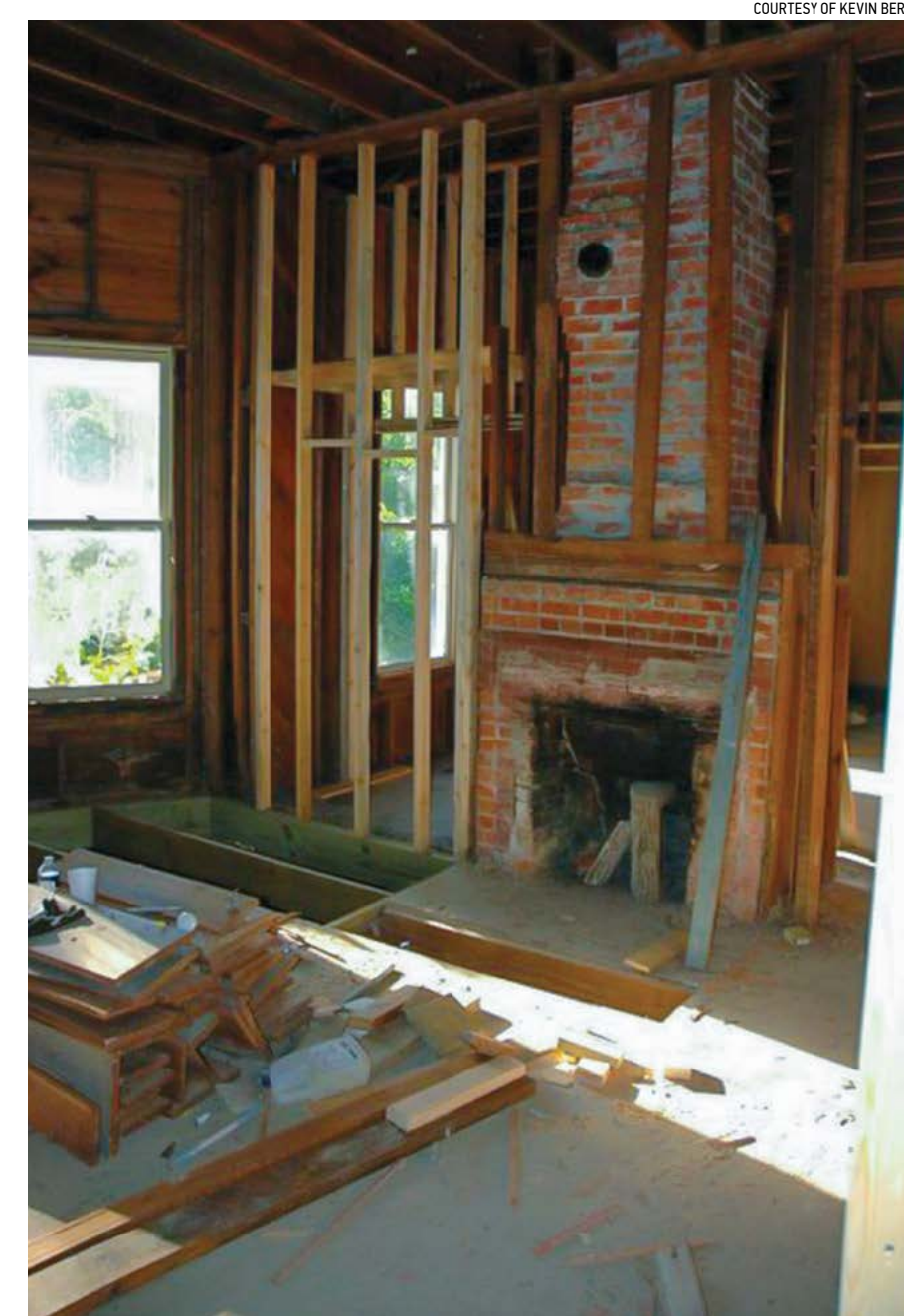
Khu vực lò sưởi đang được xây dựng trong ngôi nhà tên Conway.
