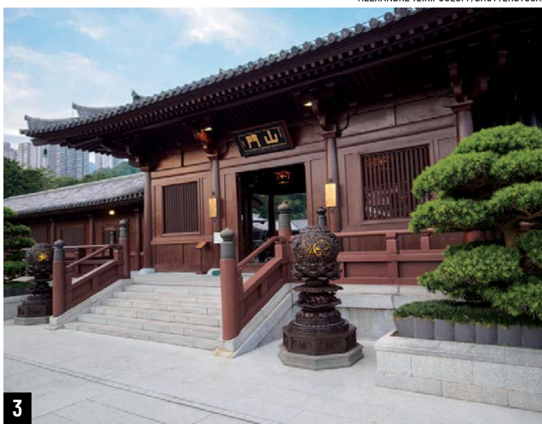
Chú thích: Đẩu Củng là một cấu trúc của Trung Hoa cổ xưa, gồm các khối gỗ (đấu) và các tay xà ngắn (củng) được đeo sao cho khi chồng lên chúng sẽ đan cài vào nhau để tạo thành một khối vững chắc mà không cần dùng đinh (kỹ thuật ghép mộng gỗ).
