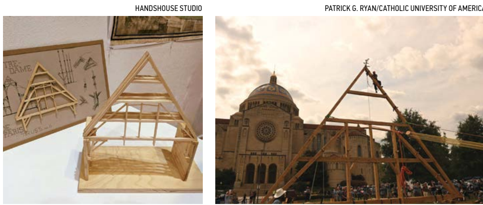
Trái: Dự án giàn đỡ Nhà thờ Đức Bà của Handshouse Studio đã tái tạo một trong những giàn đỡ mái cổ kính nhất của Nhà thờ Đức Bà Paris. Handshouse Studio đã tuân theo thiết kế, sử dụng những vật dụng và kỹ thuật nguyên bản các thợ mộc thời trung cổ đã dùng để xây dựng cấu trúc ban đầu; Phải: Dụng bản sao giàn đỡ mái Nhà thờ Đức Bà lên phía trước Vương cung Thánh đường Đền thánh Quốc gia Đức Mẹ Vô nhiễm Nguyên tội (the Basilica of the National Shrine of the Immaculate Conception) ở Hoa Thịnh Đốn vào ngày 03/08/2021.
