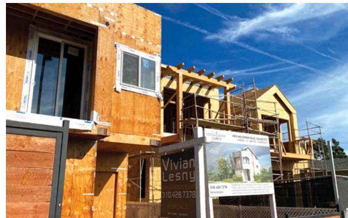
Một ngôi nhà đang được xây dựng ở Los Angeles vào ngày 21/11/2020.
