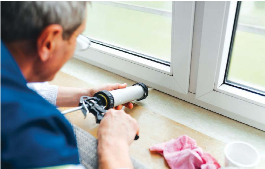
Bạn hãy kiểm soát tất cả cửa sổ và những cửa ra vào xem có bị hư hỏng hay thiếu ron hay không, và sửa chữa nếu cần thiết.
