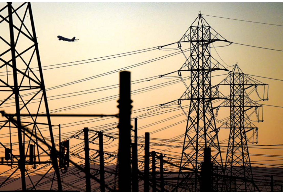
Đường dây điện lực hoành hành ở El Segundo, California, vào ngày 31/08/2022.
