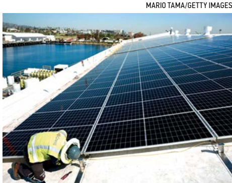
Một công nhân lắp đặt các tấm pin mặt trời trong giai đoạn hoàn thiện mái nhà năng lượng mặt trời rộng 4 mẫu Anh trên đỉnh cơ sở nghiên cứu và phát triển của AltaSea ở Khu phố San Pedro, Los Angeles hôm 21/04/2023.
